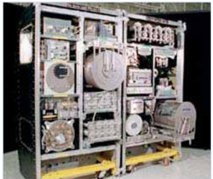
Wasseraufbereitungssystem auf der Internationalen Raumstation (Bild: NASA/Dimitri Gerondidakis)
