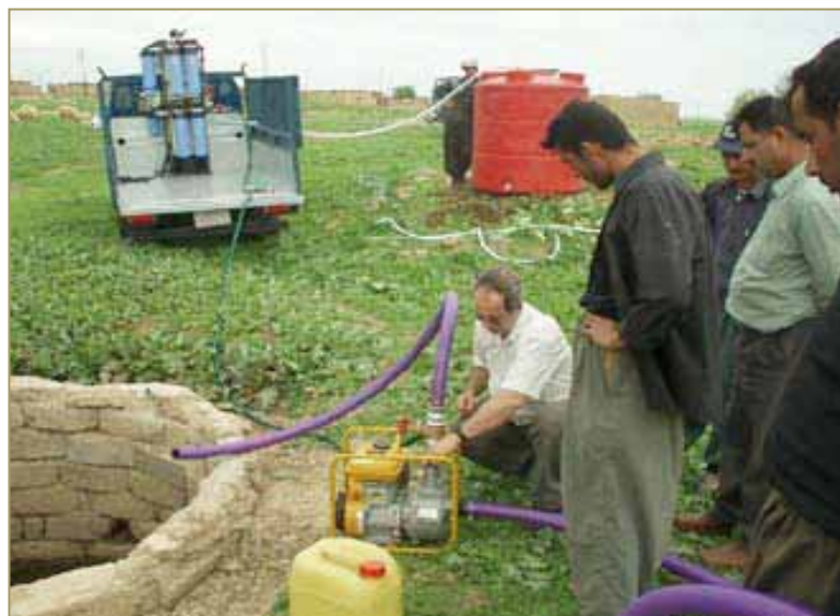
Ehrenamtliche Helfer bei Installation und Test einer Wasseraufbereitungsanlage in Kendala, Irak (Bild mit freundlicher Genehmigung von Concern for Kids)
